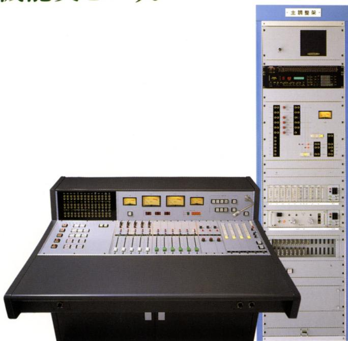
放送業務の集中操作を実現したラジオ局用主・副調整装置
